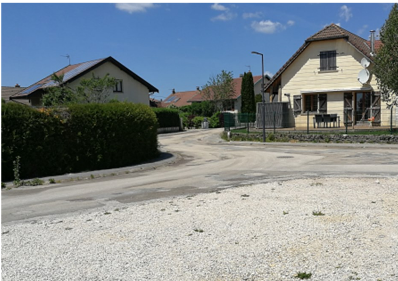
Vue de l'actuelle voirie du lotissement des Cygnes
