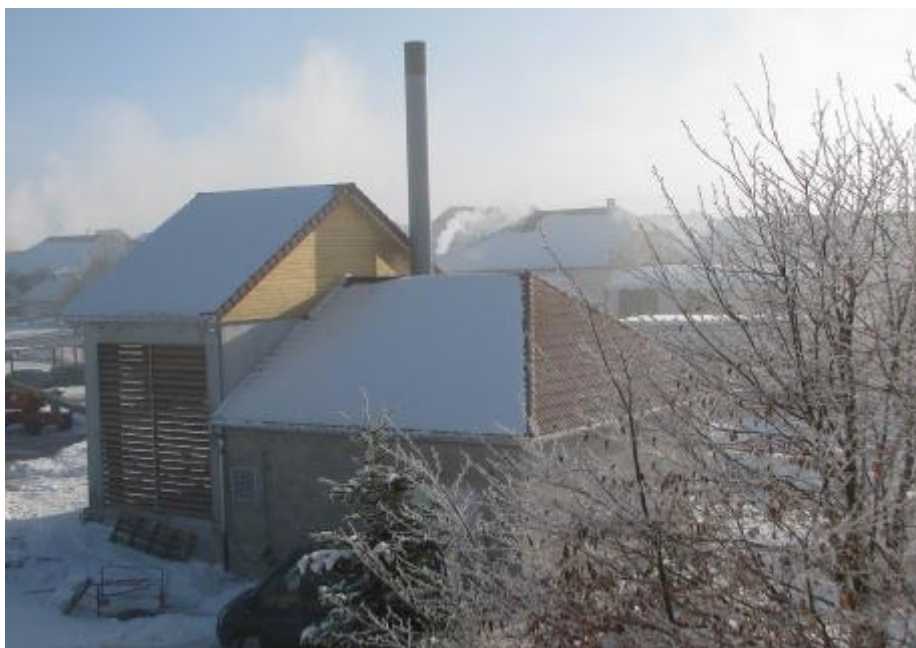
La chaufferie sera opérationnelle après 6 mois de travaux
