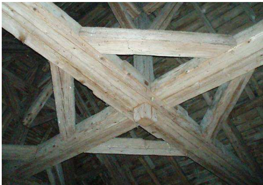
Un modèle de charpente en parfait état
