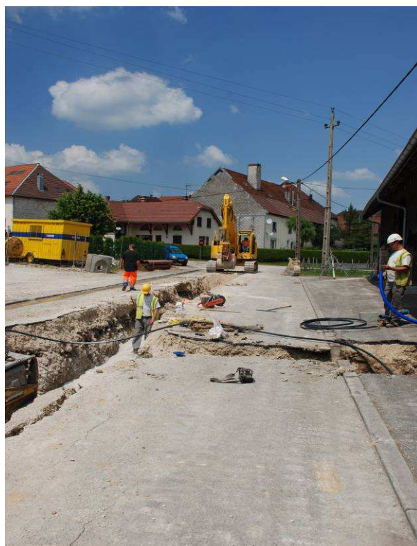
Travaux assainissement rue du Lhotaud
